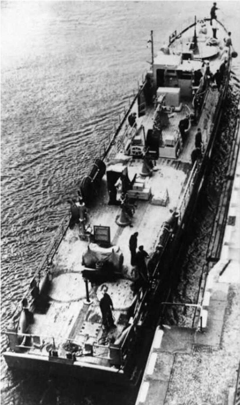
Les R-Boot équipés de propulseurs Voith Schneider se reconnaissent aux deux ouvertures circulaires au niveau de leur poupe, donnant accès au mécanisme.
